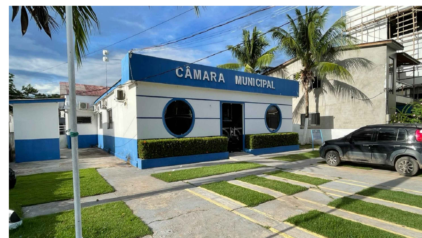
PREDIO SEM REFORMA (IMAGEM ATUAL) escala: SEM ESCALA
